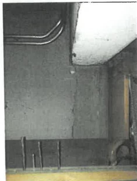
Murs fissurés sous charges des poutres du plancher haut de rez de chaussée
