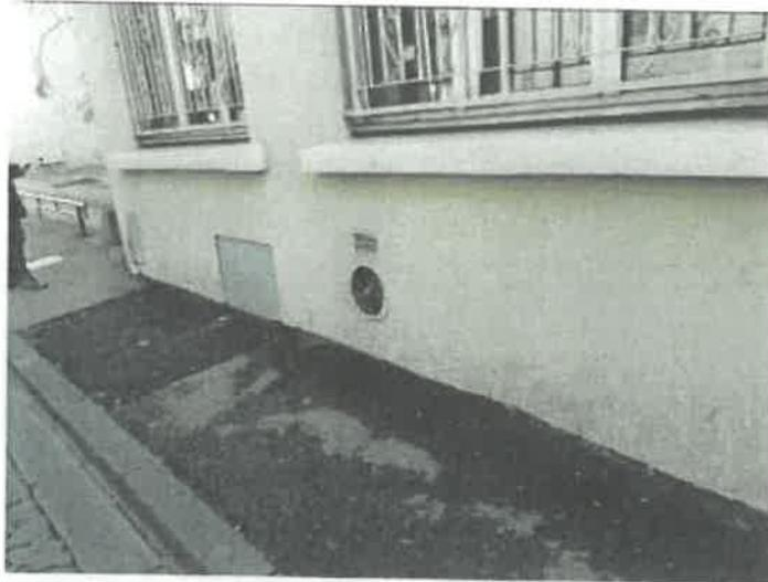
Ventilations de la chaufferie dans allèges en rez de chaussée du local voisin
